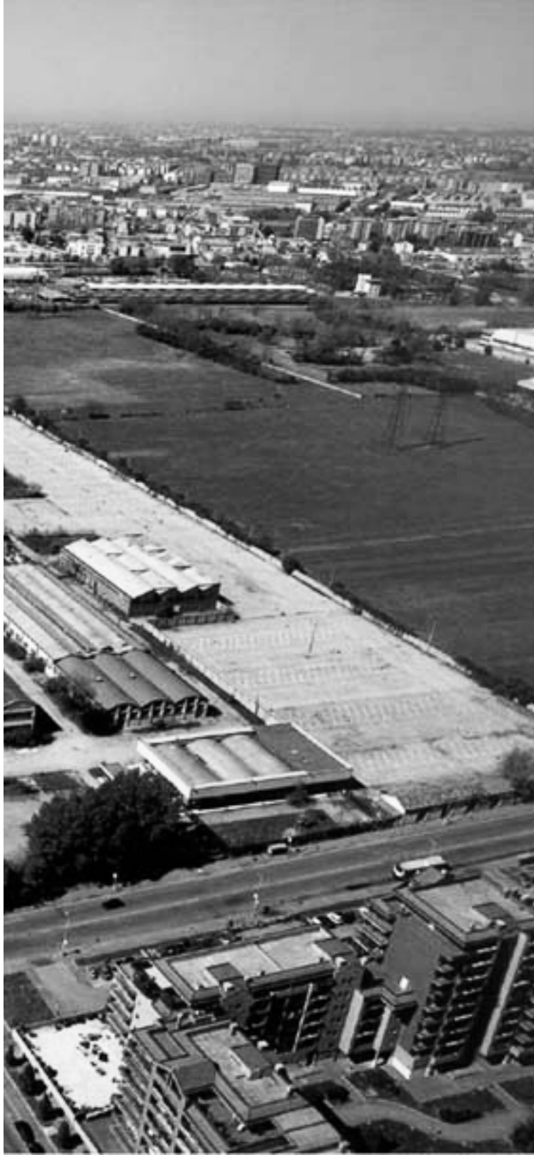
Figura 6_Vista aérea da antiga fábrica da Magneti Marelli Fonte: Arquivo hitórico da Cidade de Milão
